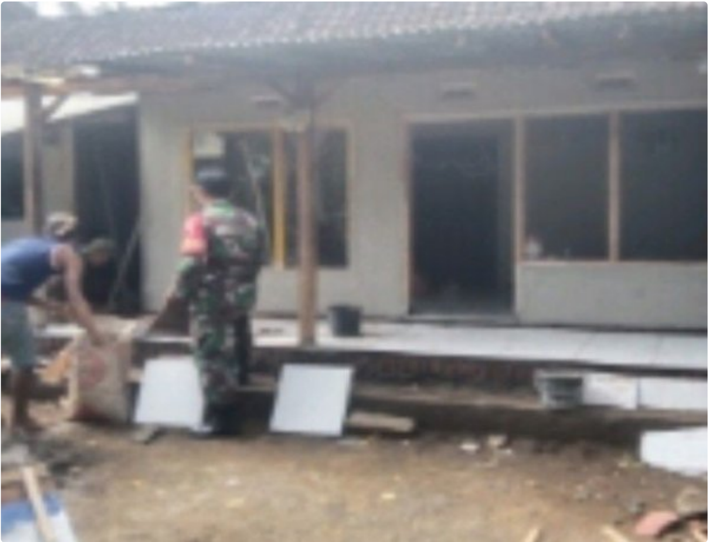
JEMBER - Pengerjaan renovasi rumah tidak layak huni (Rutilahu) Kodim
